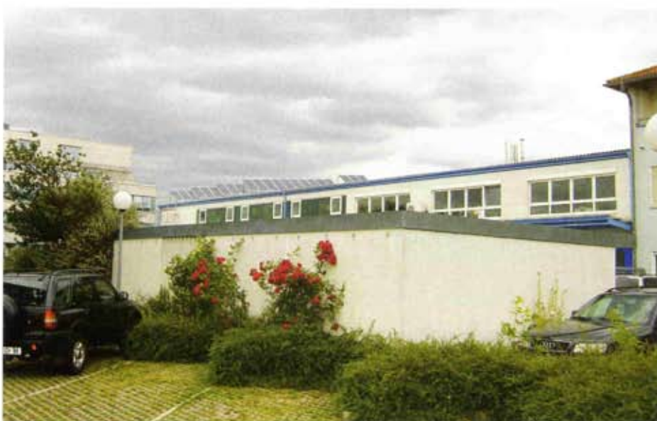
Foto 6 – Sistema de coletores na cobertura
