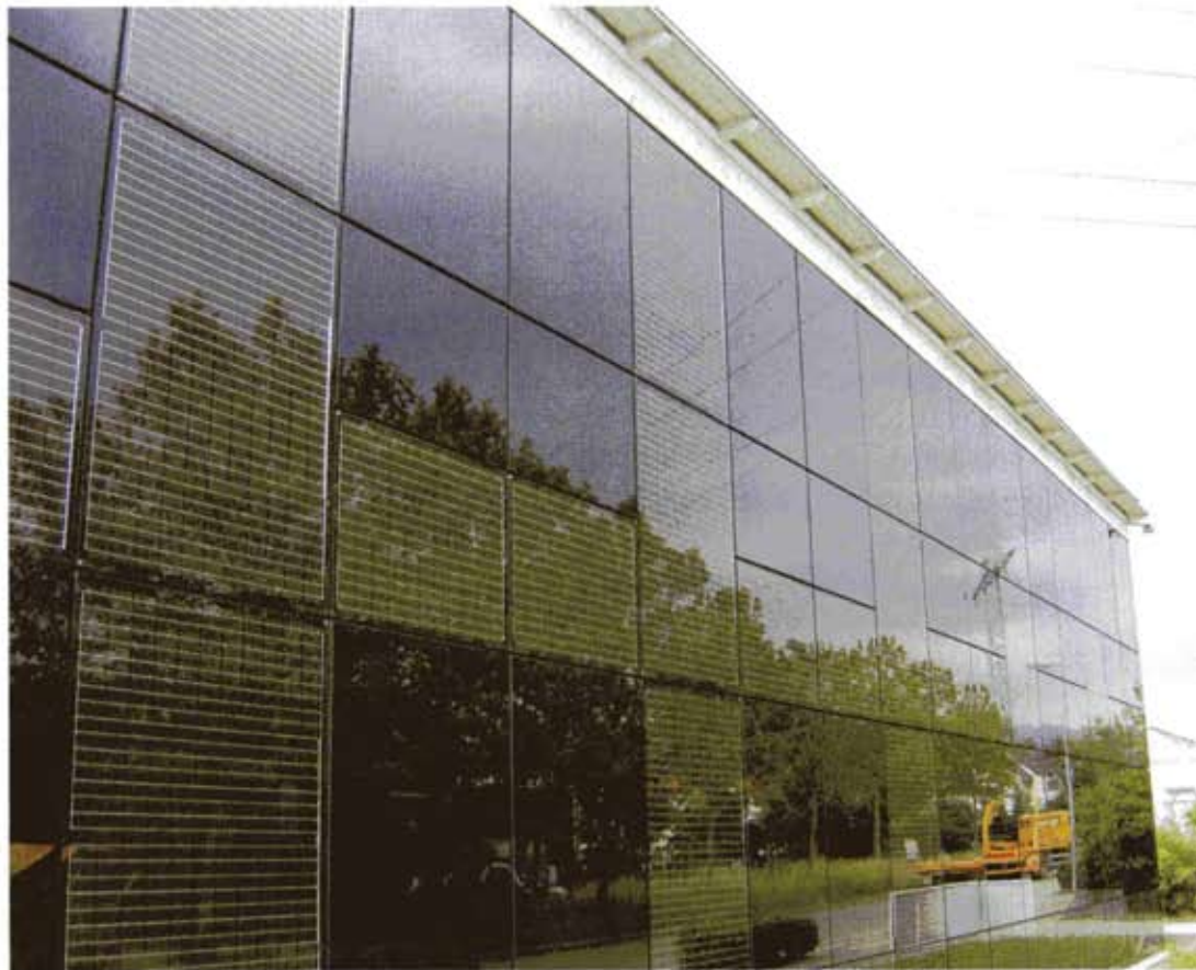
Foto 3 – Módulos solares de tecnologia monocristalina
