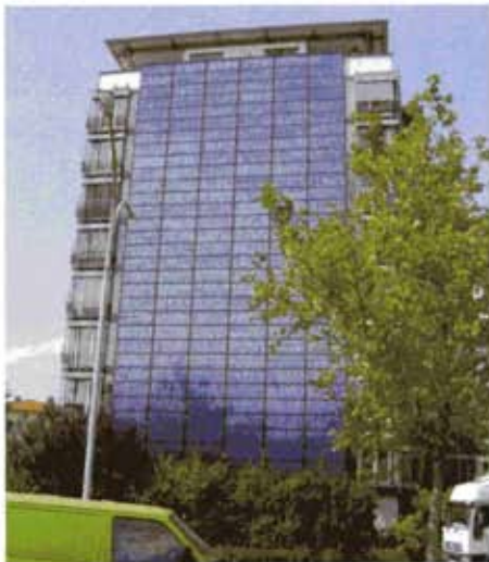
Foto 2 – Composição de fachada com coletores fotovoltaicos
